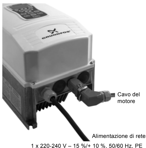
Fig. 12 Collegamenti del convertitore
