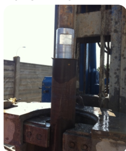
Tagliatubi inserito all'interno del tubo di rivestimento Casing cutter inside a casing tube.
