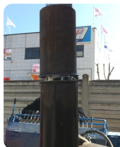
Tubo di rivestimento tagliato in due parti dal tagliatubi inserito all'interno Casing tube divided in two parts by the casing cutter.
